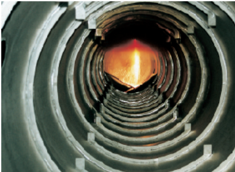
Innenansicht einer Kolonne/ Inside surface of a refinery tower
